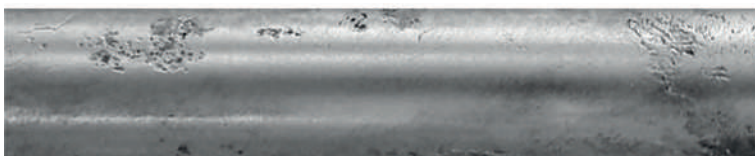
Fig. 10: Immagine del danno dovuto a corrosione bimetallica su un tubo metallico causata da braccialetti inadeguati.
