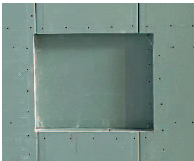
Fig. 29: Nicchia rivestita con pannelli GKBI.
