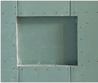
Fig. 13: Nicchia rivestita con pannelli GKBI.
